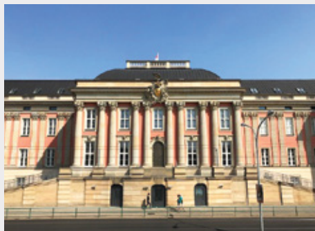
Le Parlement de Brandenburg, Allemagne – Le GMA Garnet™ ClassicCut 80 utilisé pour réaliser des supports de fixation sur mesure pour l'extension du Parlement.
